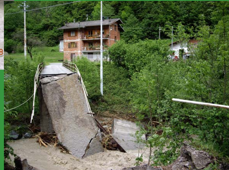
Valle Grana: crollo ponte (alluvione maggio 2008)
