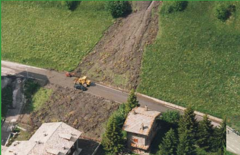
Valle Varaita: foto aerea colata detritica (alluvione 2000)
