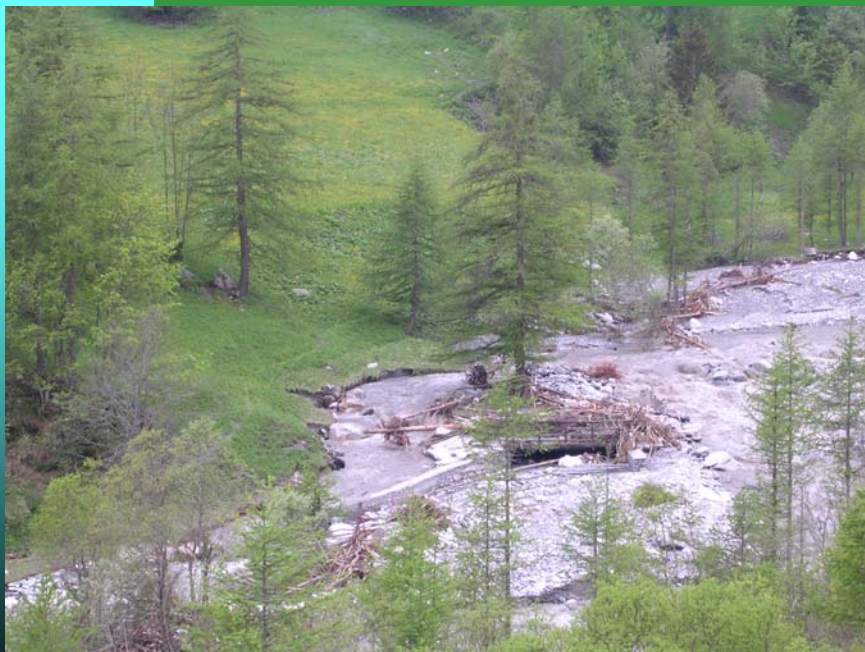
Bellino: aggiramento ponticello dal torrente Varaita (alluvione maggio 2008)
