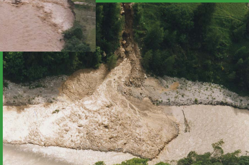
Valle Varaita: foto aerea colata detritica e conseguente deviazione del flusso della corrente (alluvione 2000)
